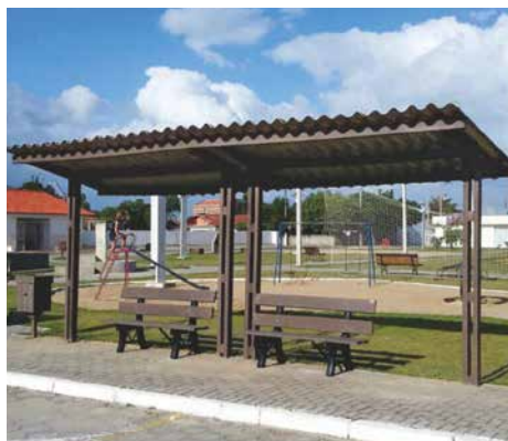
Abrigo aberto LC-31
