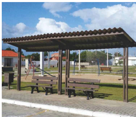
Abrigo aberto LC-31
